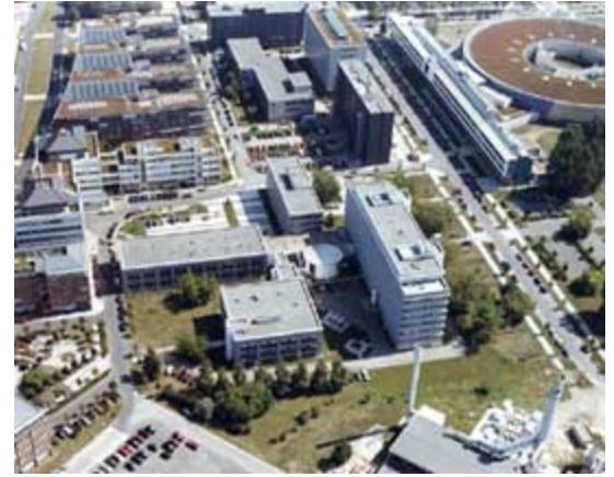
DLR-Standort Berlin-Adlershof, Luftaufnahme.
