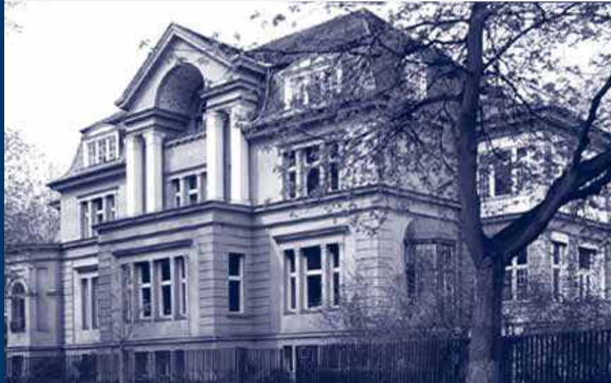
Das Hauptgebäude in der Wallotstraße
