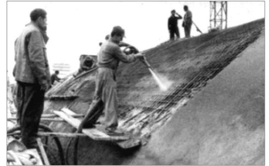
Der zwischen 1932-34 im Auftrag der DVL erbaute röhrenförmige Windkanal wurde in der **Zeiss-Dywidag-Betonschalbauweise** mit einer Wandstärke von durchschnittlich 7 cm errichtet.
