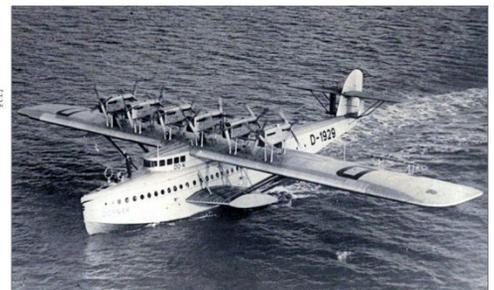
Die Abnahme und damit Zulassung der Do X mit der Kennung „D-1929“ erfolgte durch die DVL im Oktober 1930 nachdem die Motoren auf dem Prüfstand der DVL in Adlershof erfolgreich getestet wurden.
